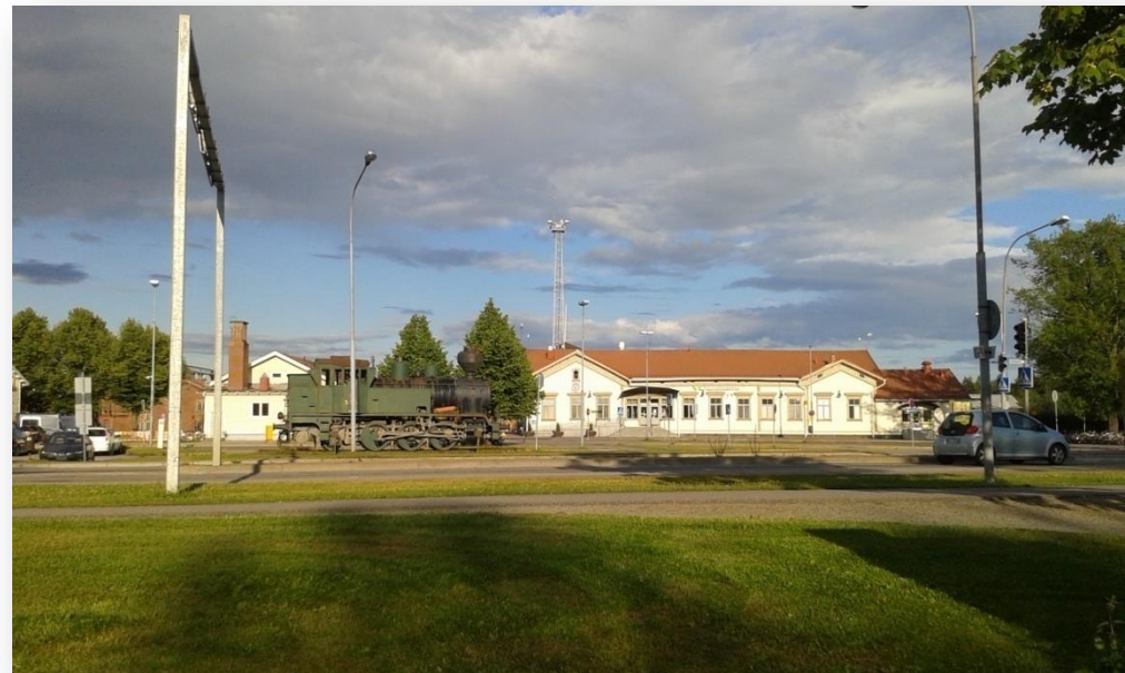
Železničná stanica – oproti hotelu
